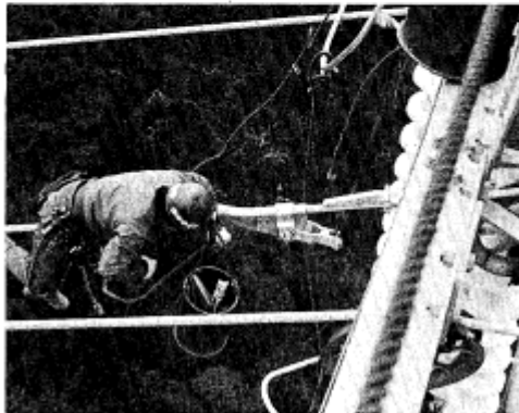
写真1 MATの仮組み
