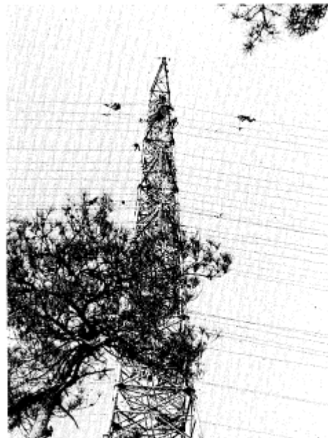
写真8 幸田分岐線38号鉄塔
