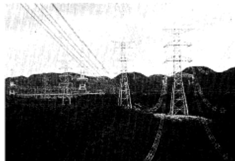
写真2 No. 213鉄塔より老側を望む
